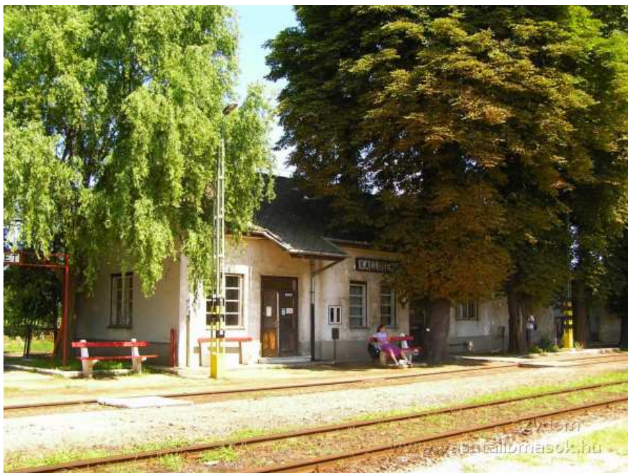
48. ábra Kállósején vasútállomás 18
