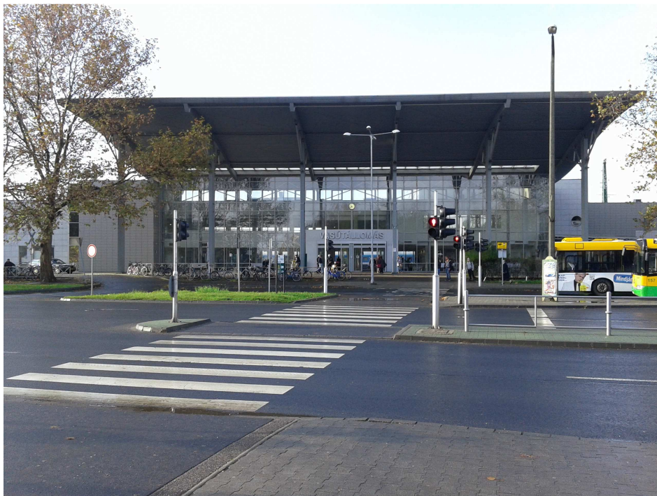
70. ábra Nyíregyháza állomás épülete az Állomás tér felől
