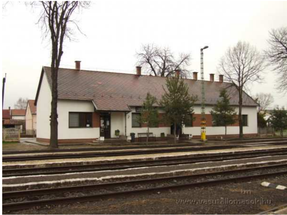
46. ábra Nagykálló állomás 16
