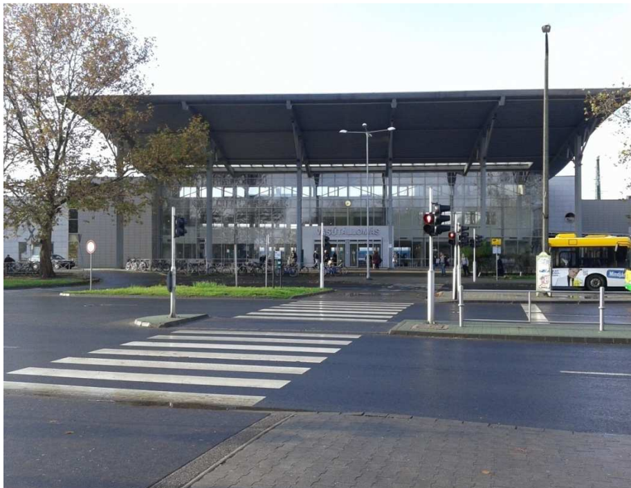
45. ábra Nyíregyháza állomás épülete az Állomás tér felől
